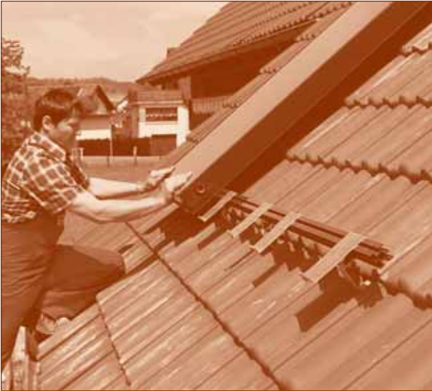
Met frame op een schuin dak
